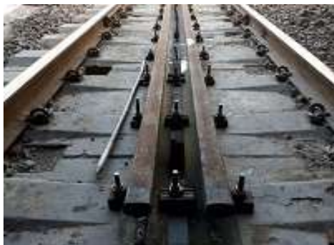
بهسازی ورودی تونل جنرال مکانیک
